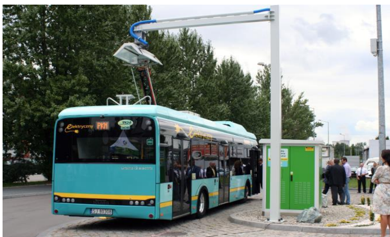
Rysunek 4. Stacja ładowania autobusów elektrycznych pantografem na pojeździe w Jaworznie
