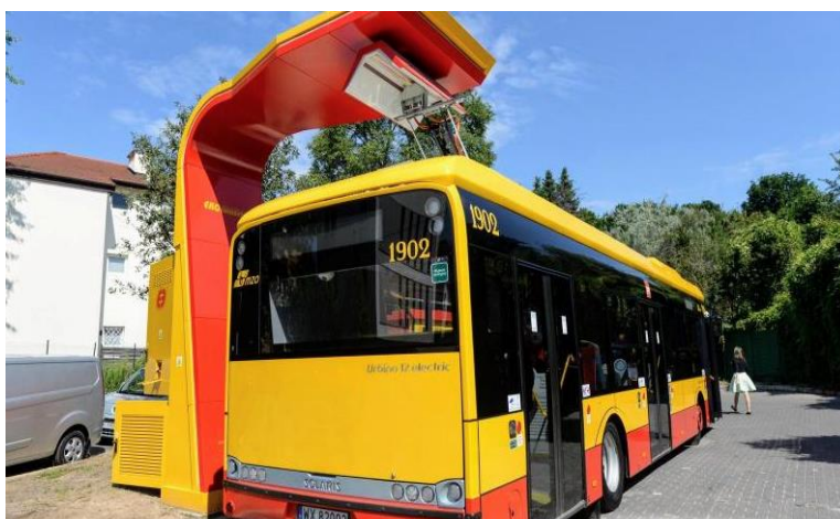
Rysunek 5. Stacja ładowania autobusów elektrycznych pantografem na pojeździe w Warszawie
