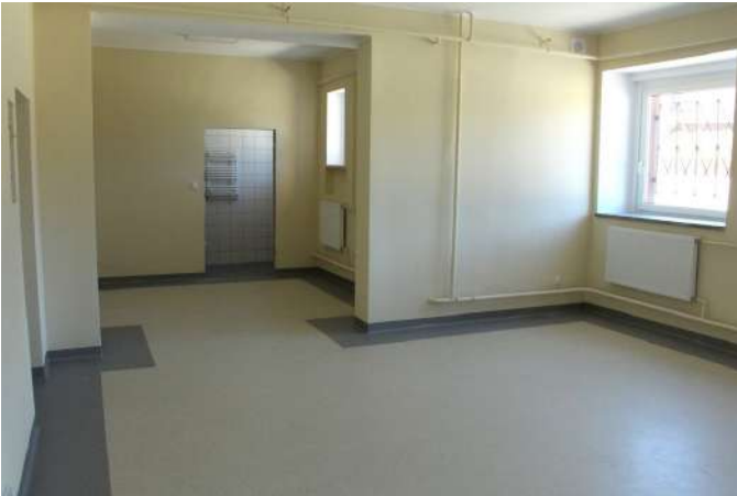
Remontowane pomieszczenia po byłym mieszkaniu woźnego w Szkole Podstawowej nr 8 będzie wykorzystane na potrzeby placówki.
