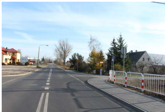
Na ul. Roosevelta (od ul. Trzemeszeńskiej do granic miasta) za 4 mln zł wybudowana zostanie kanalizacja deszczowa, a także szersza droga z nową nawierzchnią i chodnikiem. Spółka PWiK sfinansuje budowę kanalizacji sanitarnej i sieci wodociągowej. To już ostatni, 4 etap budowy kanalizacji w tym rejonie miasta.
