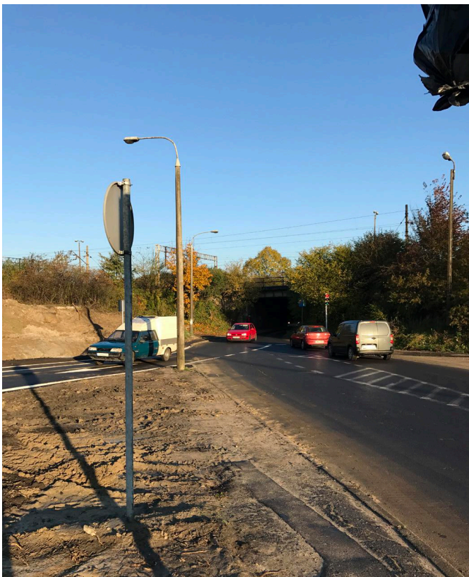
Dzięki wybudowaniu drugiej nitki na ul. Pod Trzema Mostami i rozdzieleniu ruchu, działa już tylko jedna sygnalizacja świetlna, co sprawia, że jedzie się nie tylko szybciej, ale i bezpieczniej.
