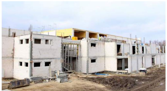
Zakończenie budowy hali widowiskowo-sportowej planowane jest na połowę 2018 r.
