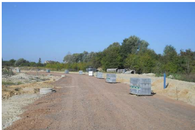
Na Osińcu powstaje nowa ulica, która służyć będzie jako dojazd do kilku dużych zakładów produkcyjnych.
