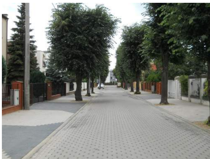
Przebudowana ul. Kochanowskiego to nie tylko nowa nawierzchnia, ale także zjazdy, krawężniki i chodniki.
