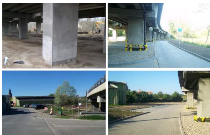
Nowe miejsca parkingowe przy ul. Żuławy – tak wyglądał teren przed i po inwestycji.
