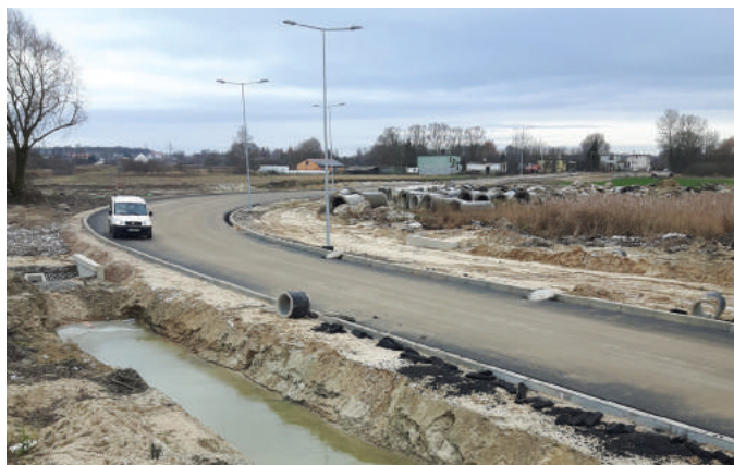
Budowa ulicy Osińiec to przedsięwzięcie zaplanowane na dwa lata.
