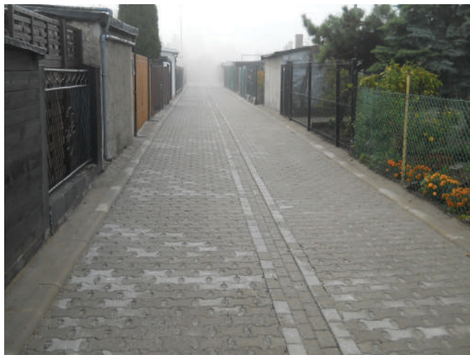
Jeden z wyremontowanych fragmentów na Osiedlu Grunwaldzkim.
