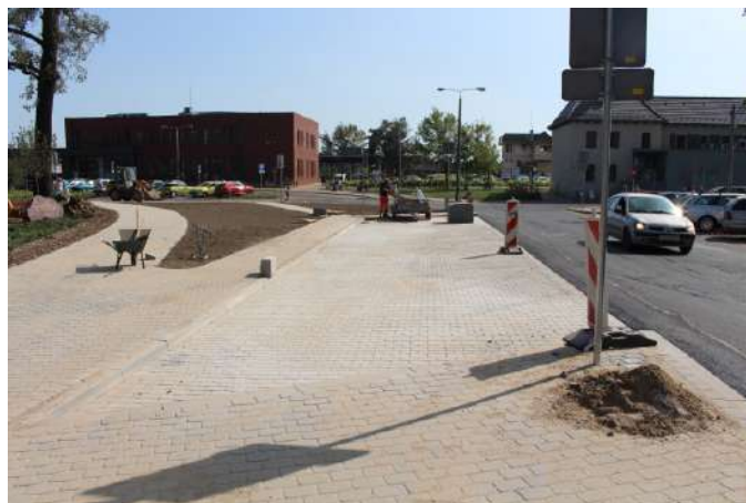
Prace wykończeniowe przy przebudowie ul. Pocztowej.
