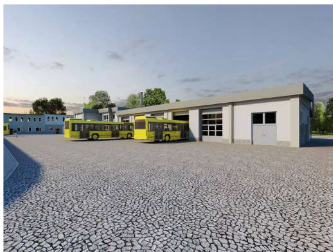
Zajezdnia autobusowa przy ul. Wesolej zostanie całkowicie przebudowana.
