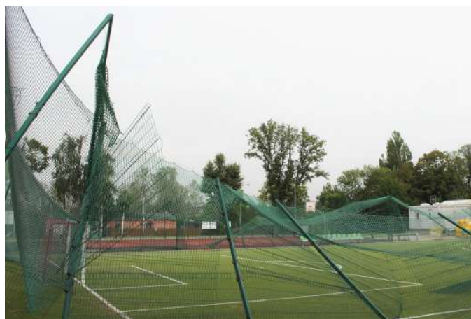
Burza zniszczyła wiele płotów i ogrodzeń, w tym to otaczające boisko Orlik przy ul. Strumykowej.
