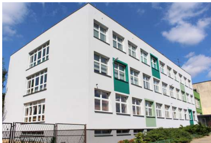
Nowa elewacja Szkoły Podstawowej nr 10.
