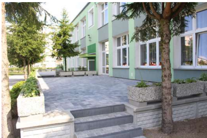
Taras w Przedszkolu nr 17 już po remoncie.
