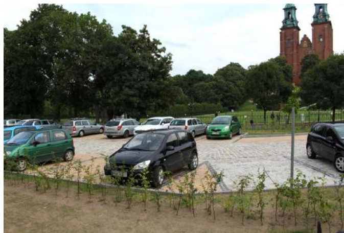
Nowy parking przy ul. Łaskiego.
