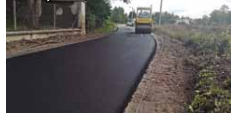
Remont drogi do Zadworza kosztował ok. 40 tys. zł.
