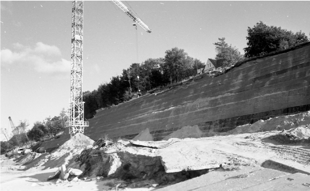
Budowa opaski gabionowej na jastrzębiogórskim klifie, fot. T. Pruszek
