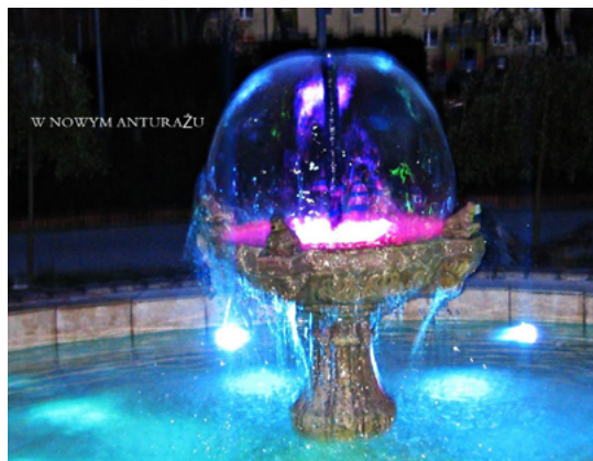
Wykonanie nowego przyłącza elektrycznego do fontanny w Rozewiu
