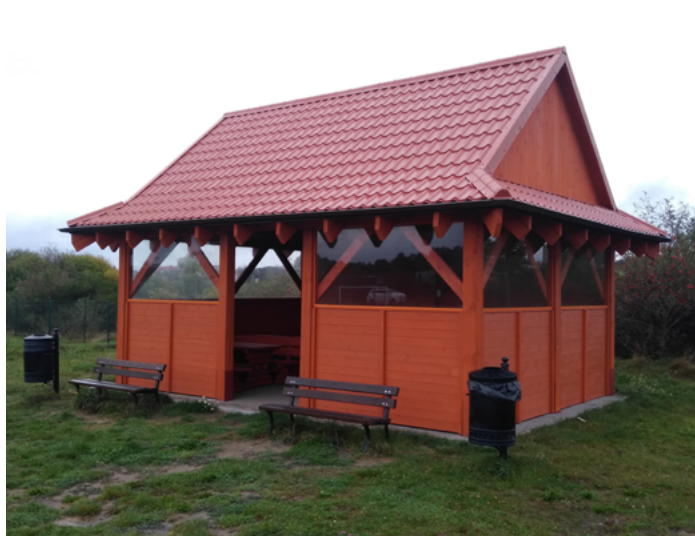
Wykonanie wiaty piknikowej na placu rekreacyjnym w Tupadłach– etap III
