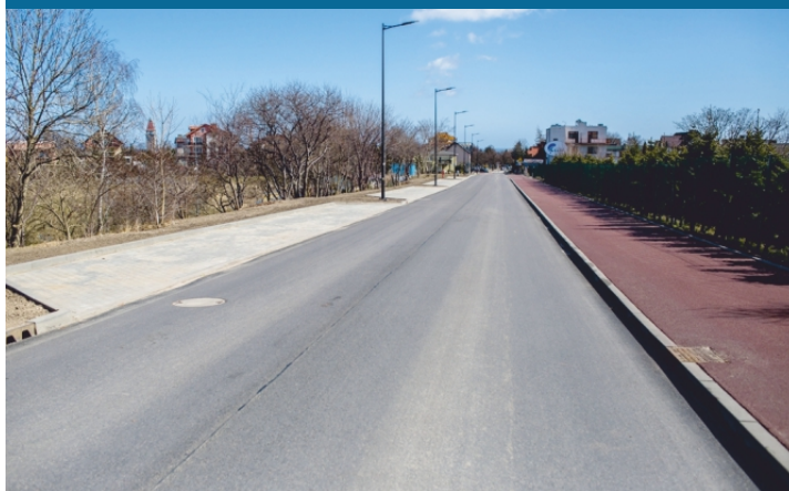
Przebudowa ul. Żwirowej we Władysławowie
