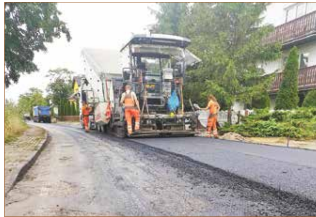
Prace przy przebudowie drogi Ośno-Zazdromin
