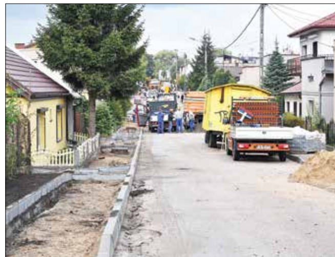
Ulica Górna. Prace trwają przy układaniu chodnika
