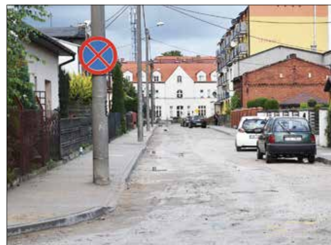
Ulica Drzewna. Przebudowanie chodnika
