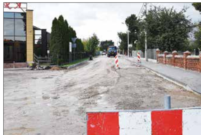
Ulica Targowa. Przed położeniem nowej nawierzchni
