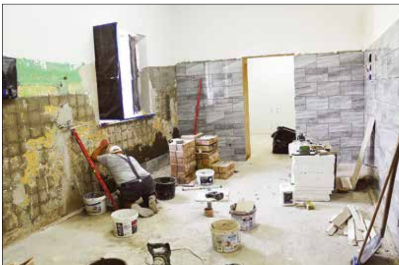
Układanie glazury w kuchni świetlicy wiejskiej w Zbrachlinie
