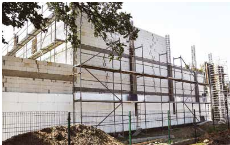
Po postawieniu murów ściany ociepla się elewacyjnym styropianem
