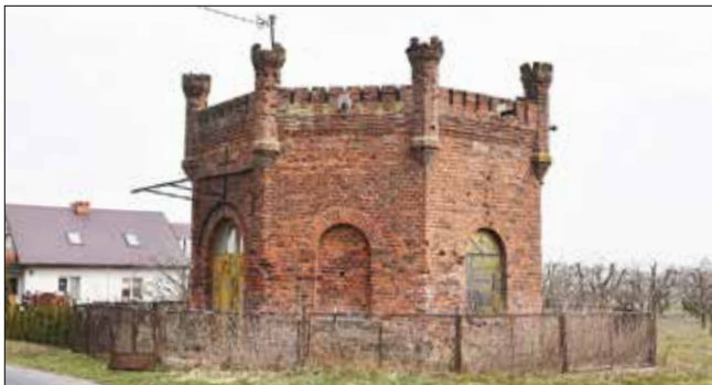
Jest to ciekawy pod względem architektonicznym zabytek
