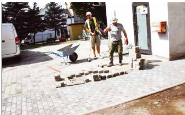
Porządkowanie terenu wokół portierni
