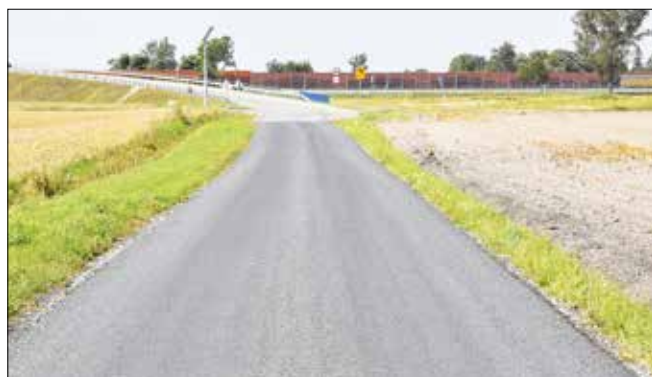
Przedłużenie zjazdu z wiaduktu w Brudnowie
