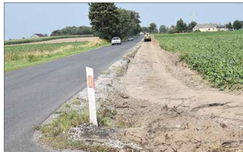
Przygotowanie miejsca pod budowę asfaltowej ścieżki rowerowej od Wagańca do Dąbrówki w gminie Raciążek
