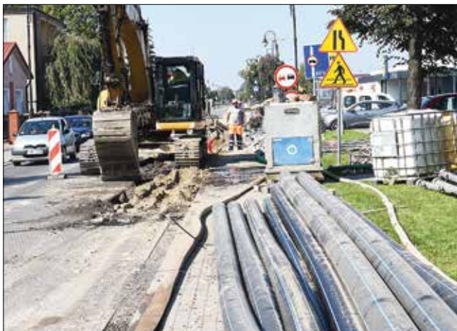
Ul. Słowackiego. Te rury na wodę są już w ziemi
