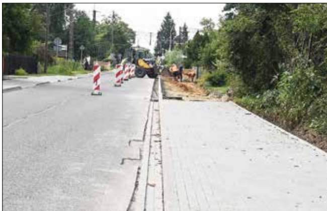
Budowa ścieżki rowerowej na ul. Kujawskiej w Wagańcu
