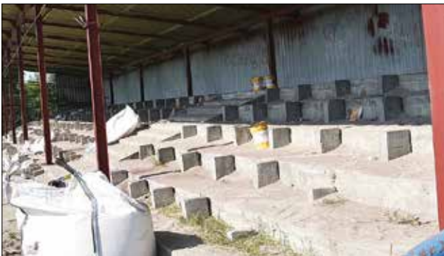
Na stadionie usunięto już stare drewniane ławki
