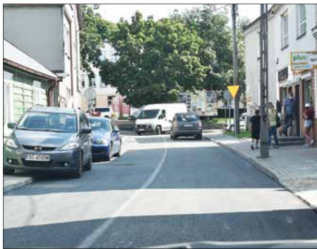
Ulica Strażacka otrzymała nową nawierzchnię
