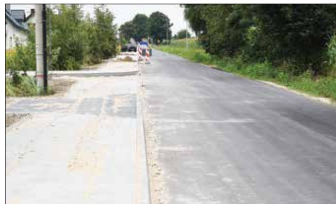
Trwa przebudowa ul. Lipowej w Nowym Zbrachlinie
