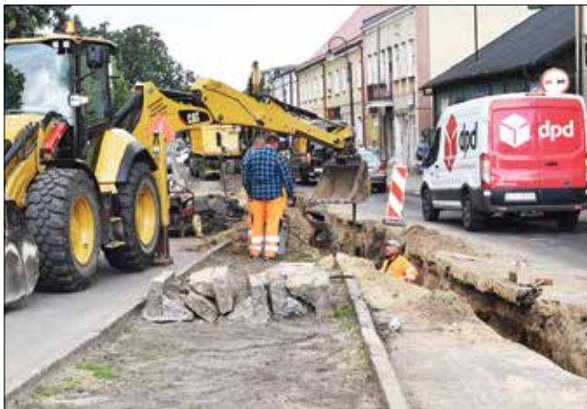
Tym razem budowana jest sieć wodociągowa
