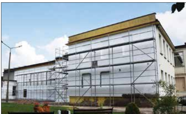
Remont MCK związany jest także z ociepleniem ścian
