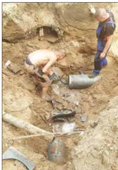
Pękła rura zasilająca w wodę miasto
