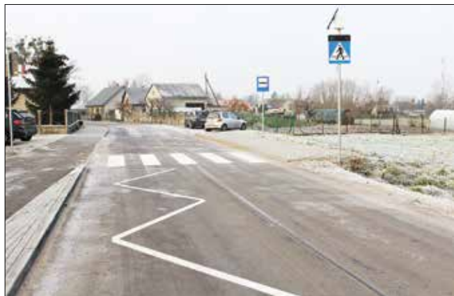
Zmodernizowana droga Straszewo - Koneck
