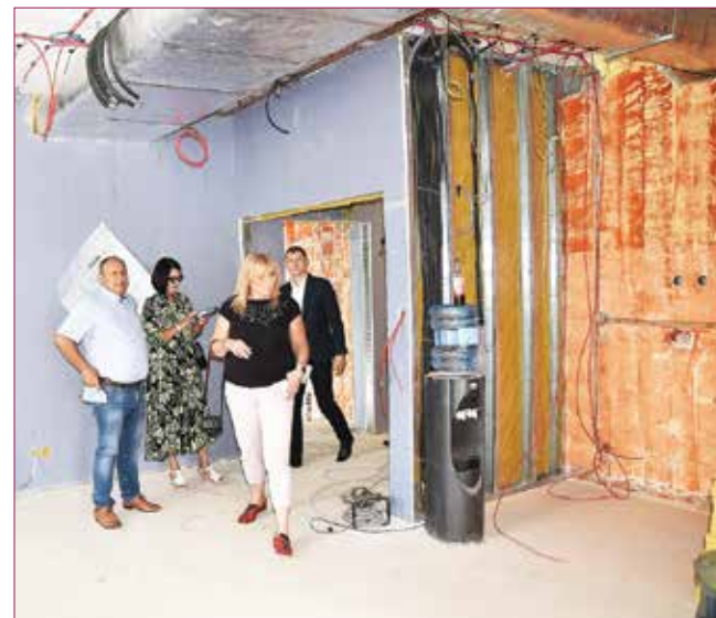
Budowa izby przyjęć pacjentów
