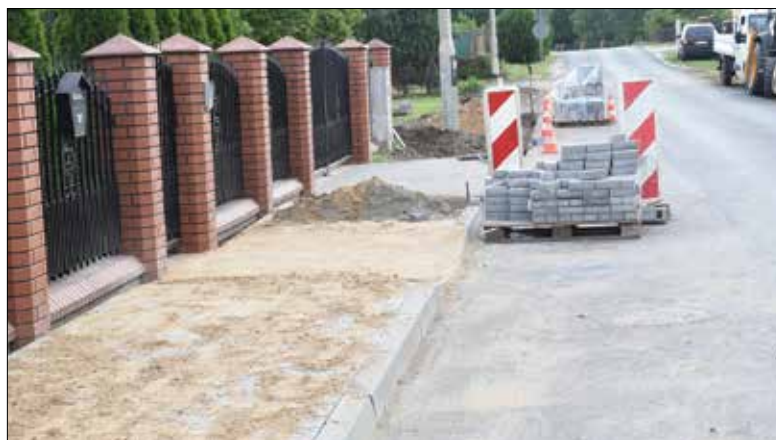
Na ul. Osiedlowej w Stawkach „Algawa” buduje chodnik
