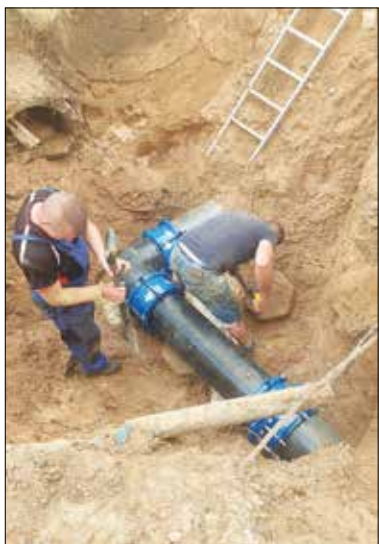
Końcowe prace naprawcze
