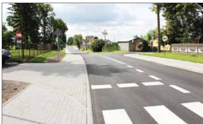
Droga Siutkowo - Ciechocinek. Oddany odcinek do Zbrachlina, trwa budowa do przejazdu kolejowego
