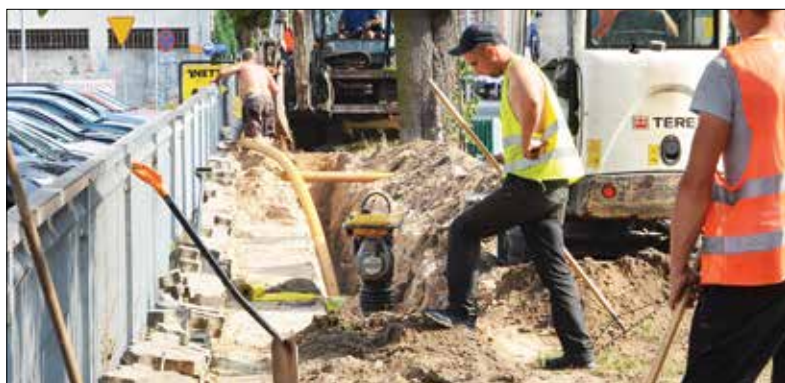
Układanie sieci gazowej na ul. Narutowicza
