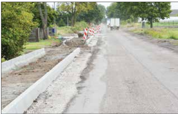
Przebudowa drogi w Ośnie
