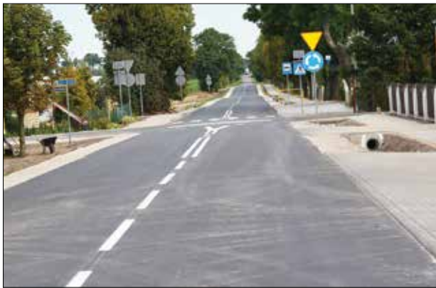
Przebudowana droga w Siutkowie
