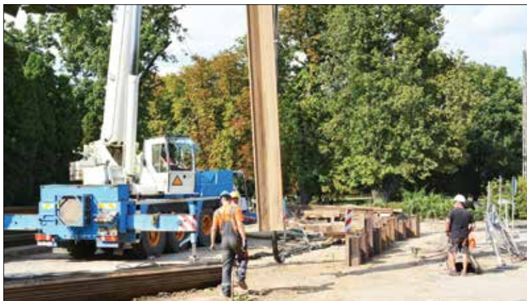
Budowa kanalizacji na skrzyżowaniu Lipowej i Wyspiańskiego
