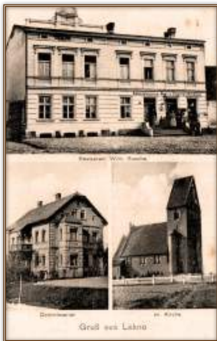
Restauracja przy Rynku (dziś: Plac Powstańców Wlkp.), budynek urzędu gminy i policji oraz kościół ewangelicki (ul. Pocztowa). Widokówka sprzed 1918 roku. Zb. prywatne.
