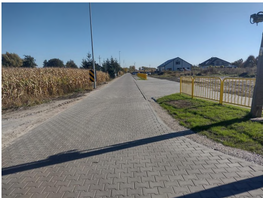
Budowa ulicy Zielonej w Dragaczu
