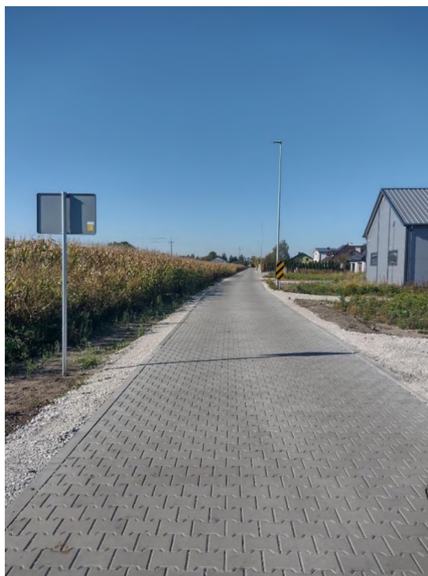
Budowa ulicy Zielonej w Dragaczu
