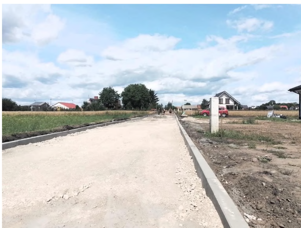
Budowa drogi w Dragaczu – III etap
