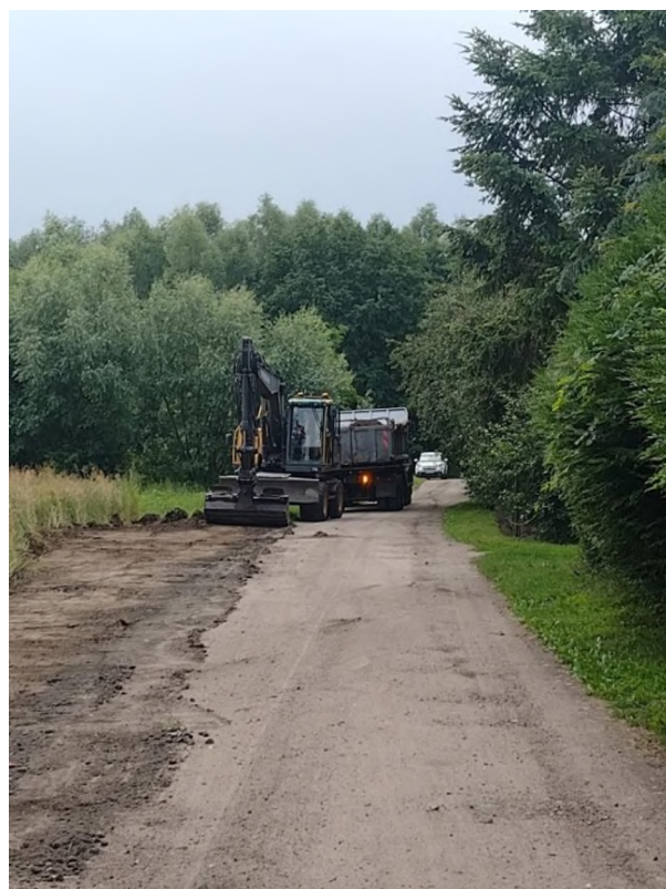
Budowa drogi w Wiąskich Piaskach
