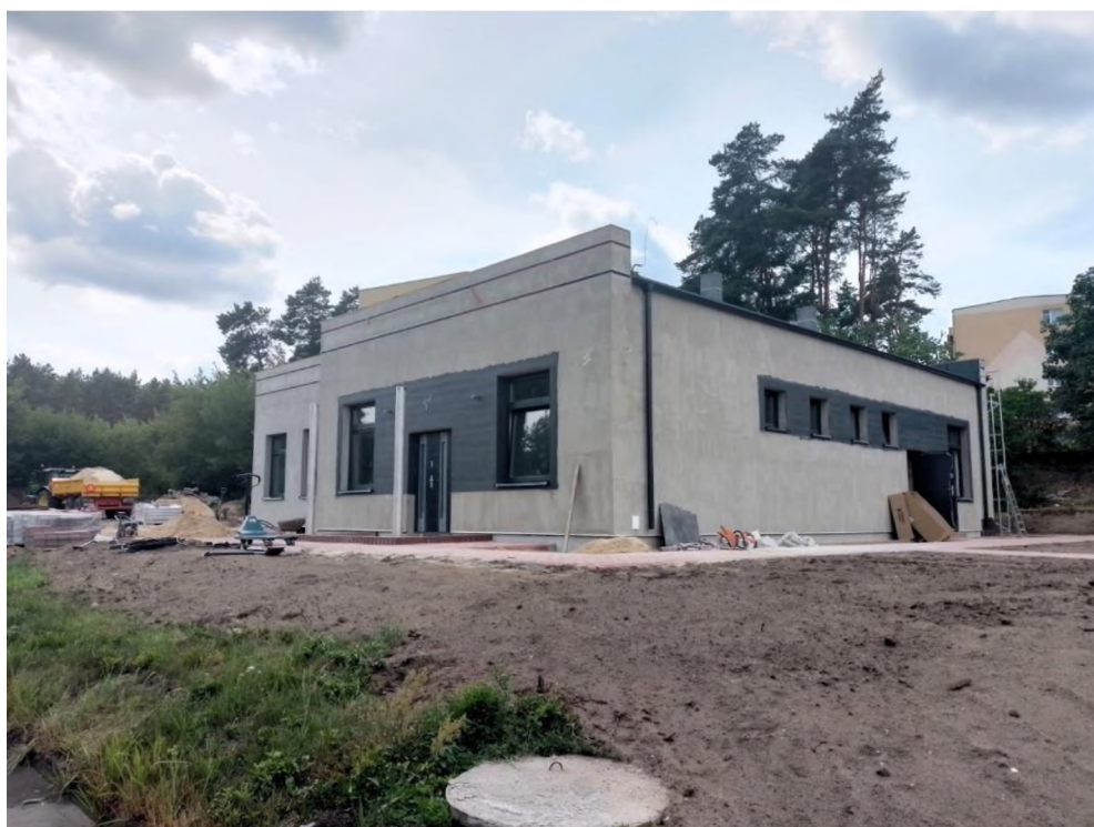
Budowa świetlicy w Grupie Osiedle
