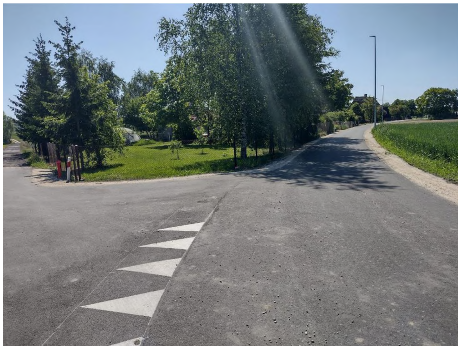
Budowa drogi w Wielkim Lubieniu
