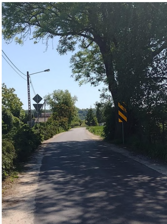
Budowa drogi w Wielkim Lubieniu
