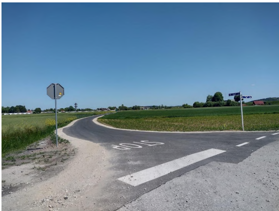
Budowa drogi w Wielkim Lubieniu
