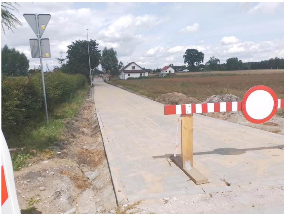
Budowa drogi w Dragaczu – III etap
