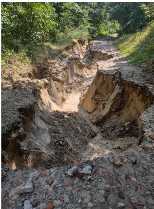
Uszkodzenia spowodowane przez anomalie pogodowe
