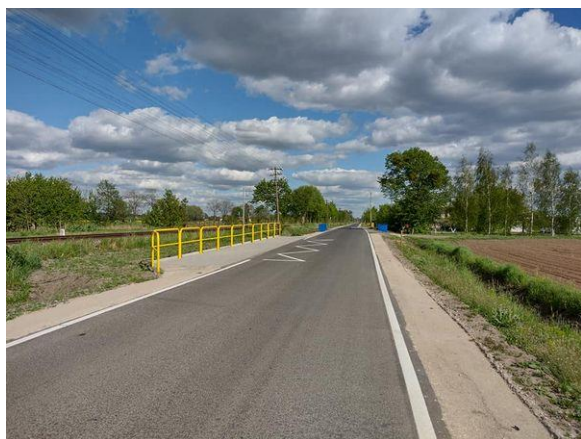
Remont drogi powiatowej Dolna Grupa – Michale.
