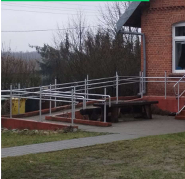
Budowa podjazdu dla osób z niepełnosprawnościami, pozyskanie drugiego pomieszczenia i remont łazienki w świetlicy w Mniszku 2017
