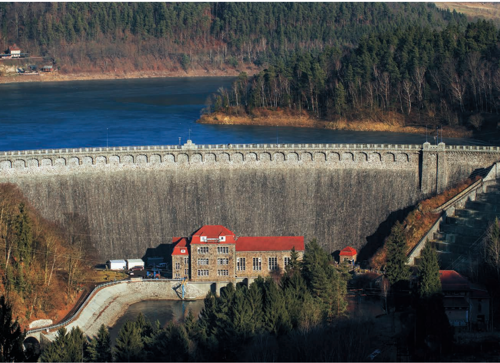
Malowniczy Zbiornik Pilchowski powstał na skutek przegrodzenia Bobru potężną tamą kamienną o wysokości przeszło 60 metrów i rozpiętości 270 metrów. U podstawy zapory zbudowano elektrownię wodną. Po prawej stronie zapory widać stopnie przelewu awaryjnego zbiornika (fot. P.Z.)
