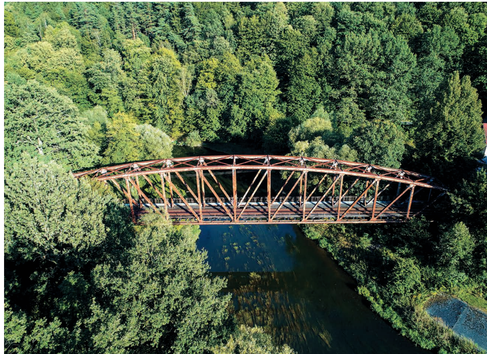
Most kolejowy Nielestno (fot. K.B.)
