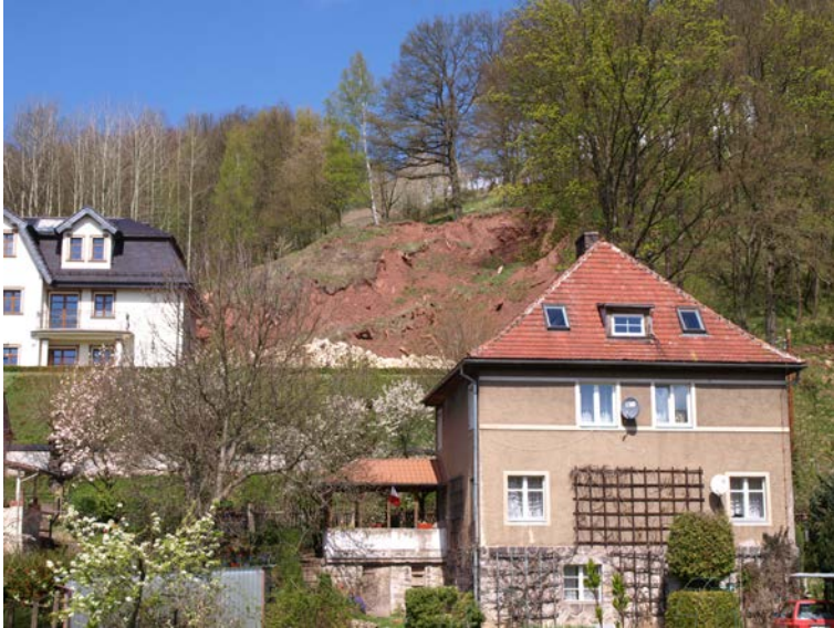
Rys. 10. Osuwisko w skarpie powyżej remontowanego pensjonatu „Leśny Dwór” (z lewej) na Osiedlu Południowym we Wleniu. Stan na 30.04.2017 r.
