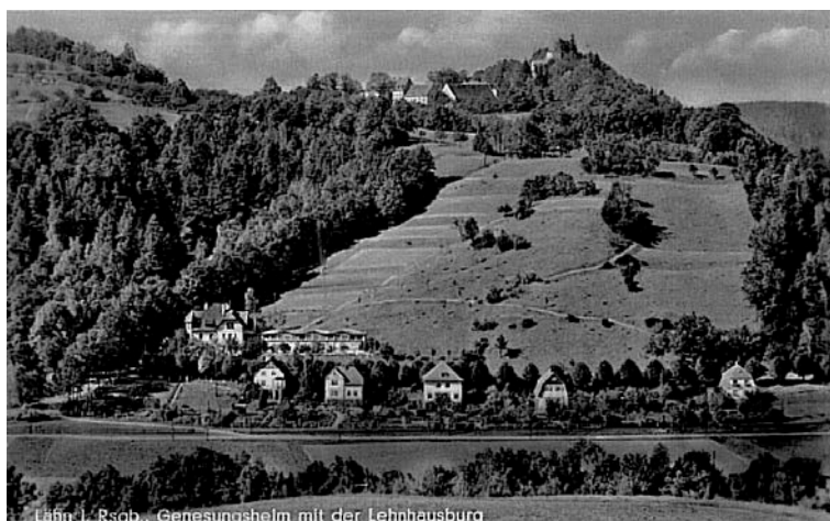
Rys. 9. Północno-zachodnie zbocza doliny Bobru w okolicy Osiedla Południowego we Wleniu. Powyżej budynku sanatorium „Leśny Dwór” widoczny starasowany stok zbudowany ze skał osadowych permu. Stok z prawej strony zbudowany z trachyandezytów ma zachowany naturalny profil. Karta pocztowa z 1939 r. (fot. Oswald Kühne, Photo-Kunstanstalt u. Verlag, Friedeberg/Isergeb.; kol. A. Kowalski).
