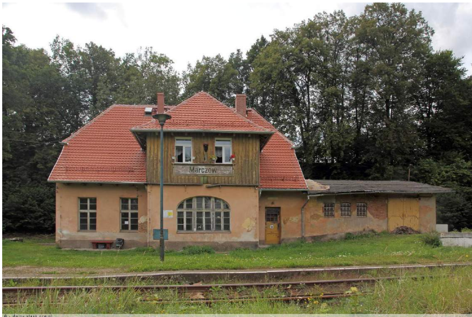
Stacja Kolejowa w Marczowie
