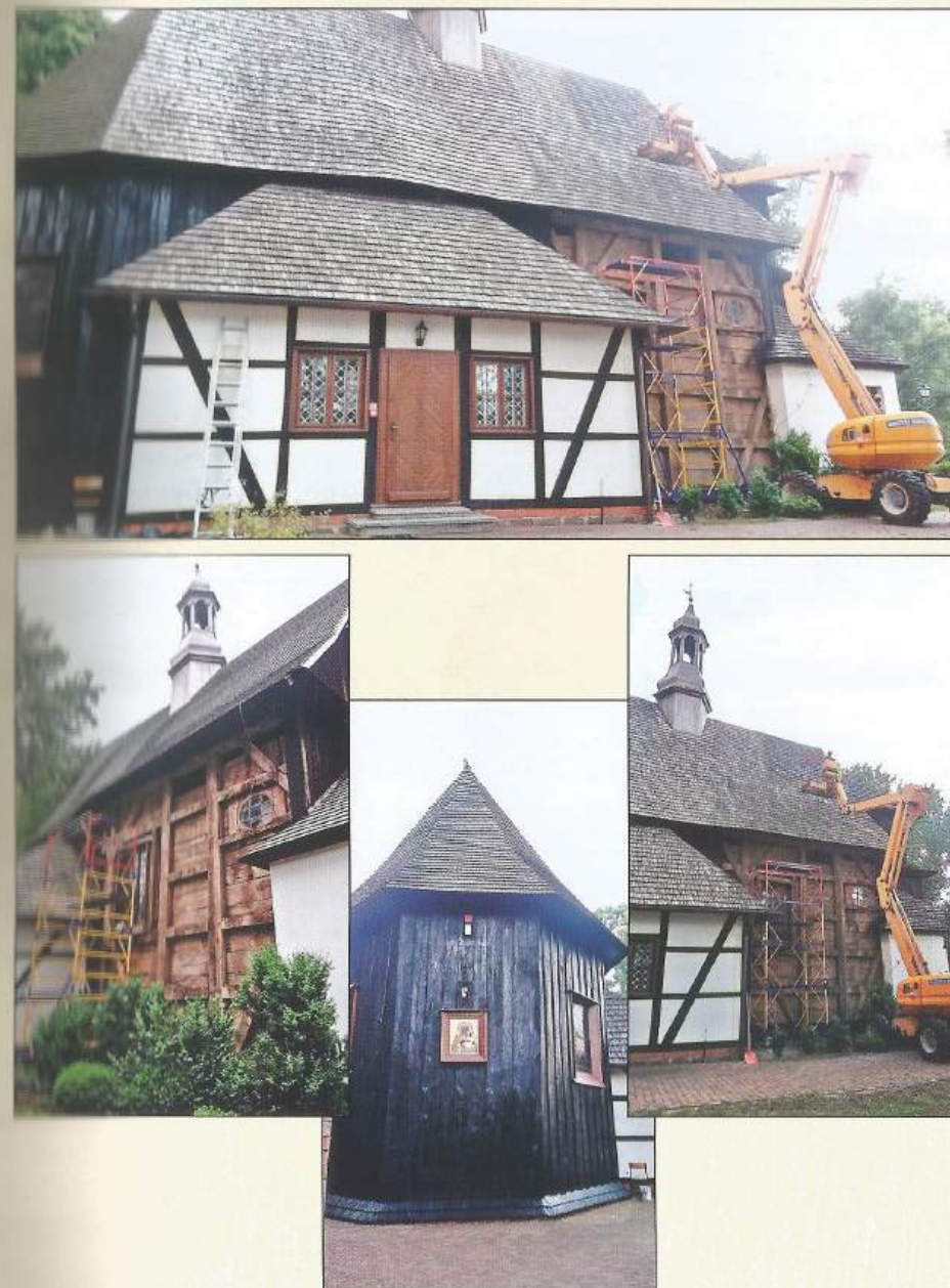
Fotorelacja z remontu kościoła parafialnego w Sośnicy.
