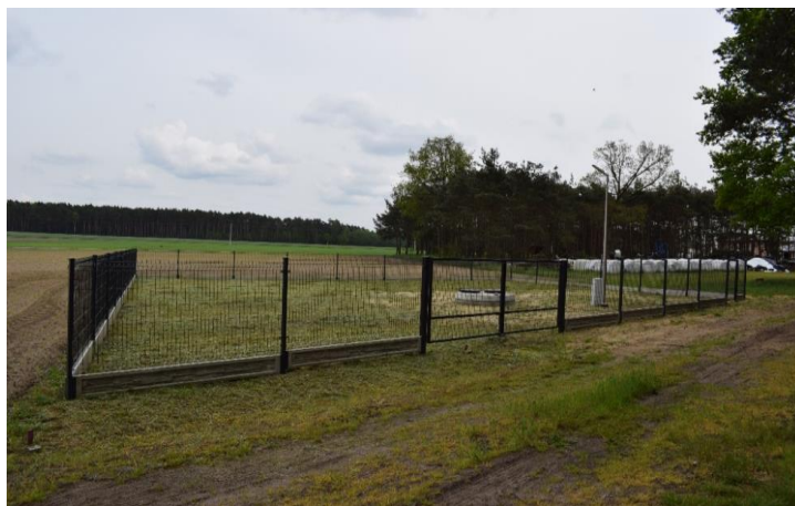
zdj. Studnia głębinowa (odwiert nr 2) w miejscowości Muchy.
