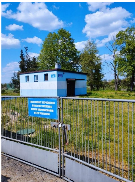
zdj. Stacja Uzdatniania Wody w Czajkowie
