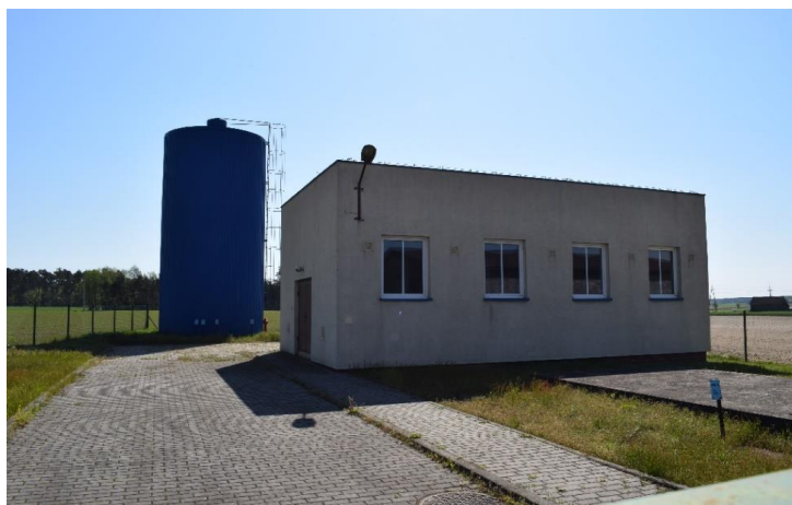
zdj. Stacja Uzdatniania Wody w Muchach
