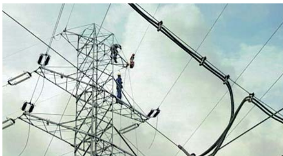
Prace modernizacyjne na linii elektroenergetycznej
