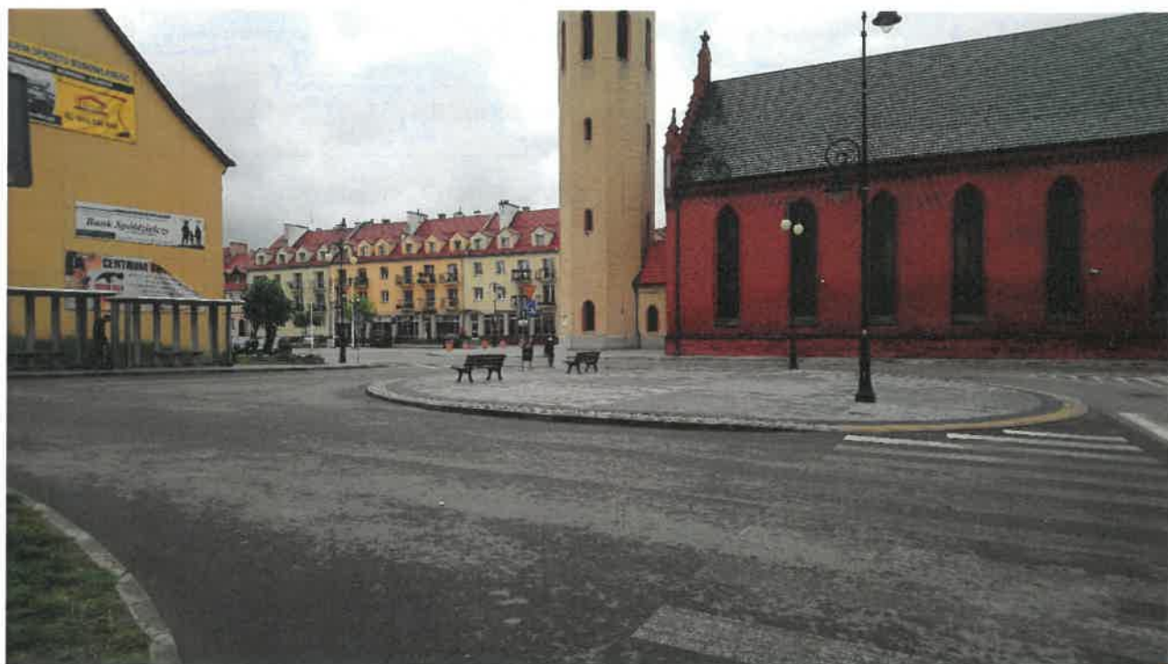
Remont zaplecza sanitarno-przystankowego przy Rynku T. Kościuszki w Nowym Stawie
