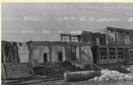
fot Budowa świetlicy i szkoły – ze zbiorów prywatnych
