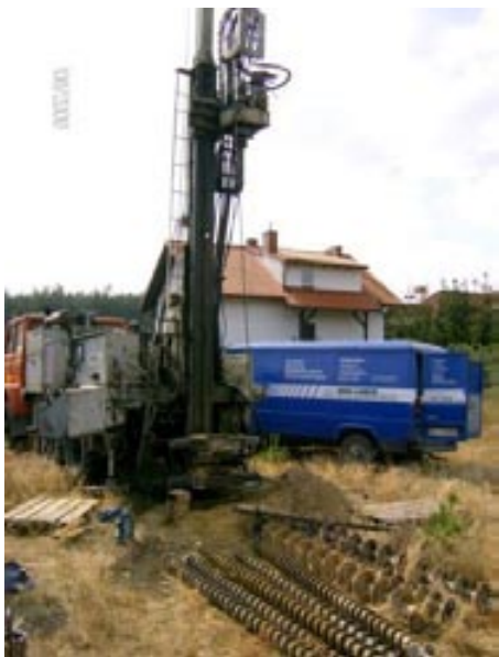
Fot. Otwory wykonane zostały przy użyciu wiertnicy mechanicznej, przystosowanej do wierceń bez użycia płuczki.
