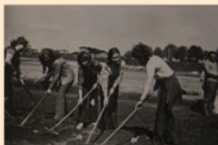
Fot. Budowa boiska w czynie społecznym (lata siedemdziesiąte)
