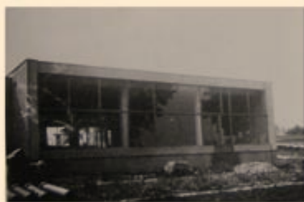
Fot. Budowa pawilonu GS, przy ul. Bydgoskiej (1974r.)
