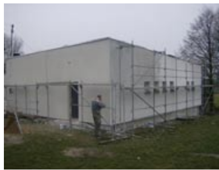
Fot. Bagienica – świetlica w trakcie robót
