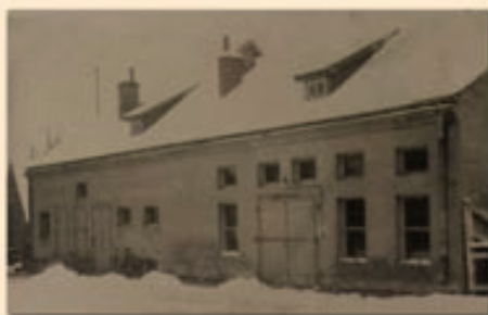
Fot. Budynek lecznicy zwierząt (1955r.)
