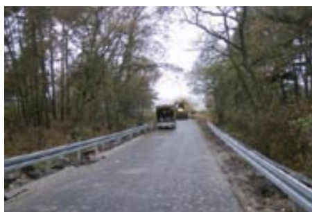
Fot. droga w trakcie prac
