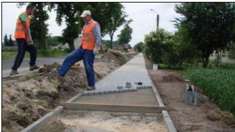
Fot. 1- Budowa chodnika w Wielkiej Kloni.
