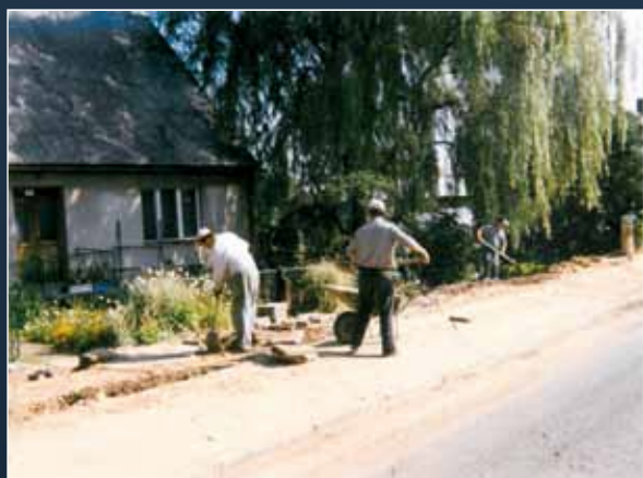
Budowa linii telefonicznej przez mieszkańców Gostycyna
