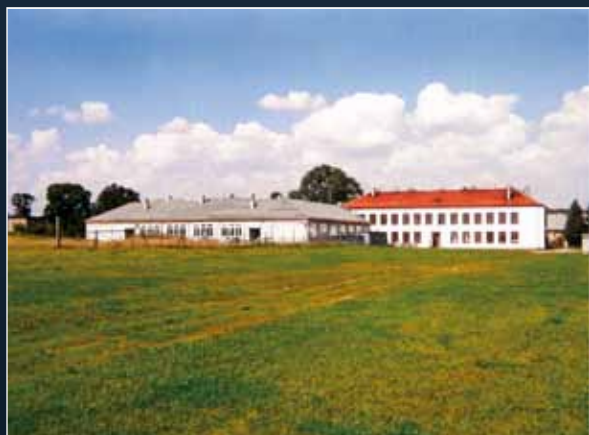
Gostycyn – budynek „Gimnazjum” w budowie
