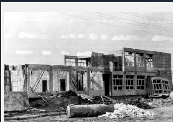
Budynek Szkoły Podstawowej w Pruszczu w budowie, wiosna 1966 r.
