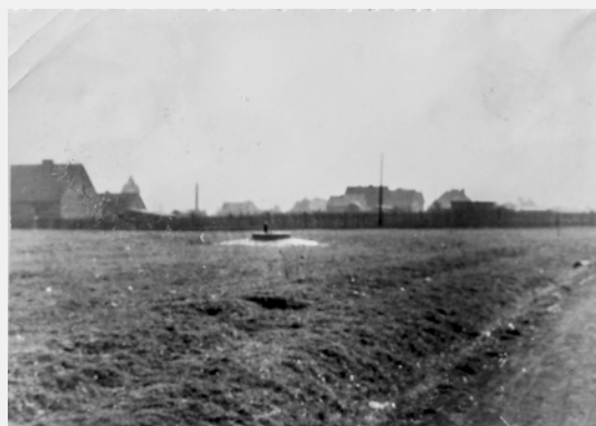
Ulica Dworcowa w Pruszczu, na terenie planowanej budowy szkoły nowa studnia głębinowa.
