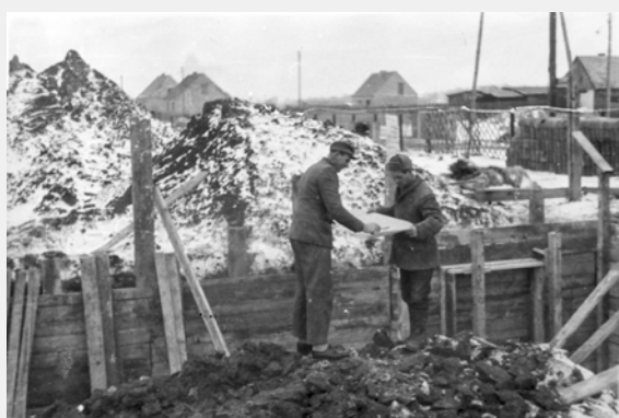
Prace ziemne budowy szkoły podstawowej, przy udziale społeczeństwa, październik 1965 roku.
