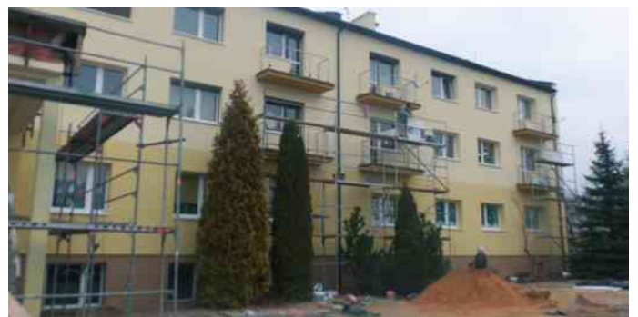
Termomodernizacja budynku oświatowo-komunalnego w Zborowskim
