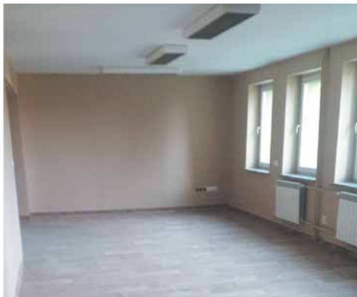
Zdjęcia wyremontowanego pomieszczenia.
