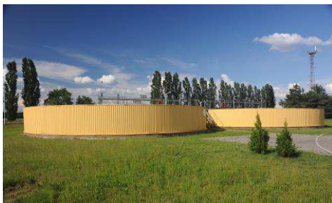
4, 5. Oczyszczalnia ścieków w Gołuchowie. Fot. T. Marcinkowski.
