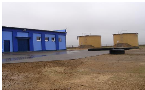
Zdjęcie 1. Stacja uzdatniania wody w Tursku
