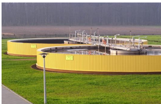
Zdjęcie 3,4. Oczyszczalnia ścieków w Gołuchowie
