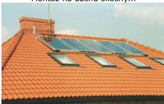
Montaż na dachu skośnym
