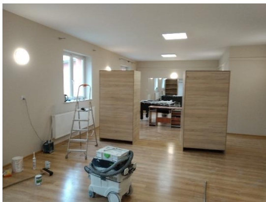
Zdj. Sala po remoncie
