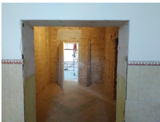
Zdj. korytarz na piętrze po rozbiórce paneli ściennych
