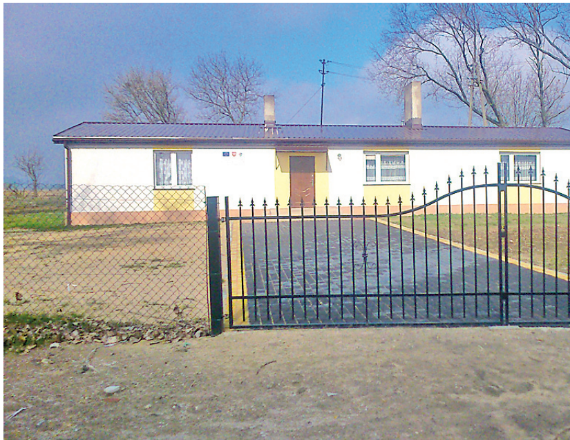
Świetlica wiejska wraz z utwardzeniem terenu wokół
