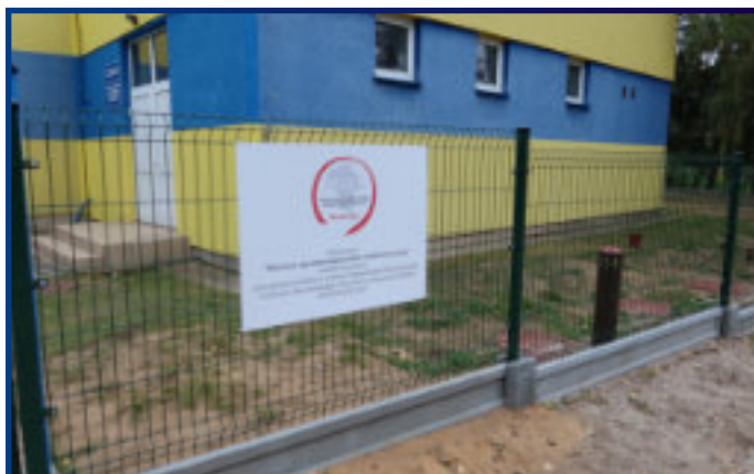
Wymiana ogrodzenia przy SUW
