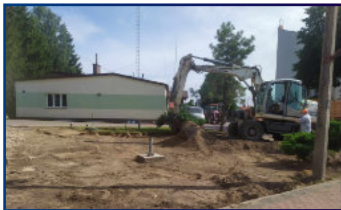
Plac przed Urzędem Gminy w trakcie prac
