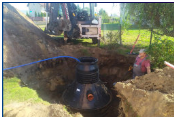
Budowa przydomowych oczyszczalni w trakcie prac
