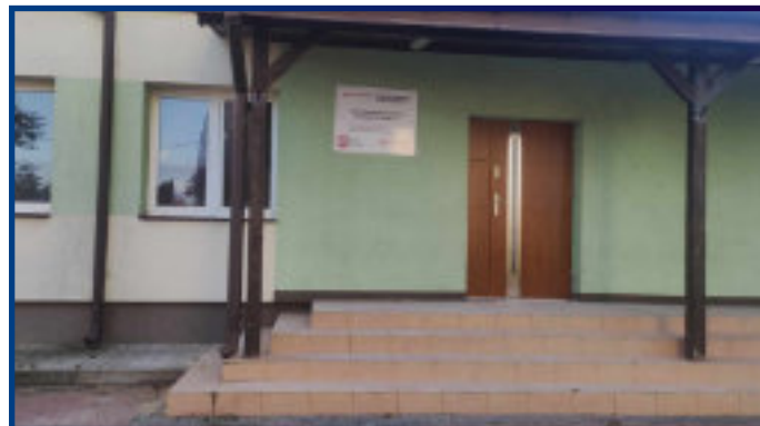
Remont świetlicy wiejskiej
