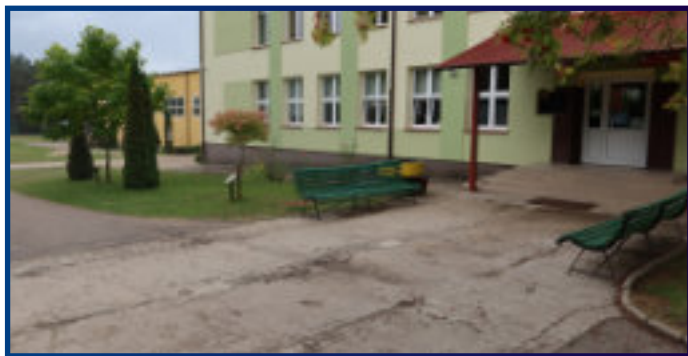
Kompleks szkolny przed modernizacją
