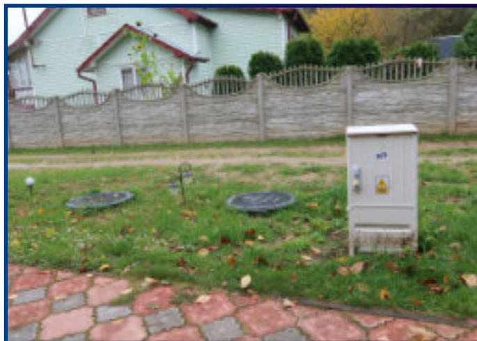
Budowa przydomowej oczyszczalni po wykonaniu
