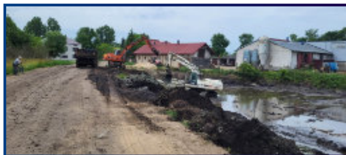
Staw w trakcie prac
