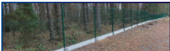
Ogrodzenie po modernizacji kompleksu sportowego
