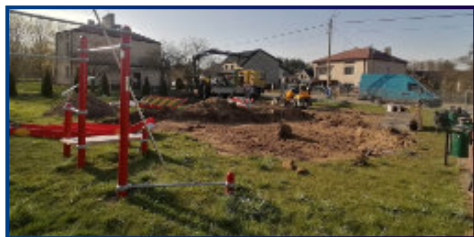
Plac w trakcie prac
