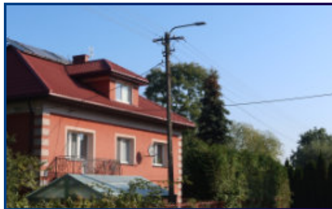
Modernizacja oświetlenia ulicznego
