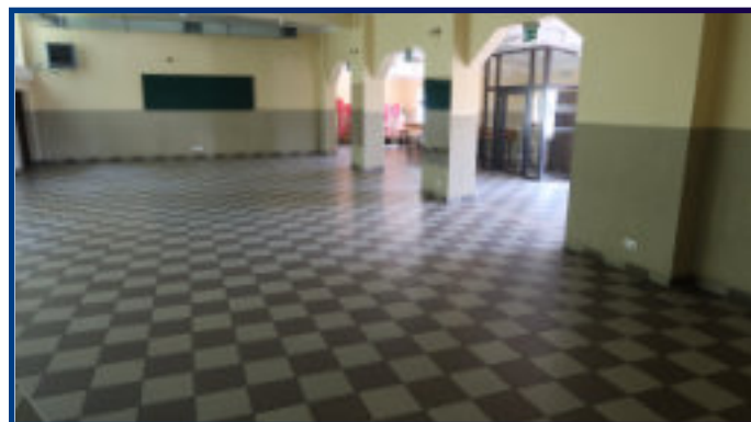
Posadzka przed remontem
