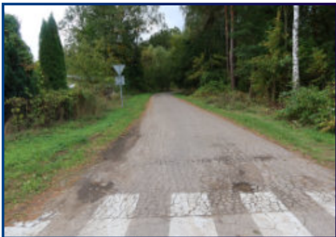
Ulica Miła przed przebudową
