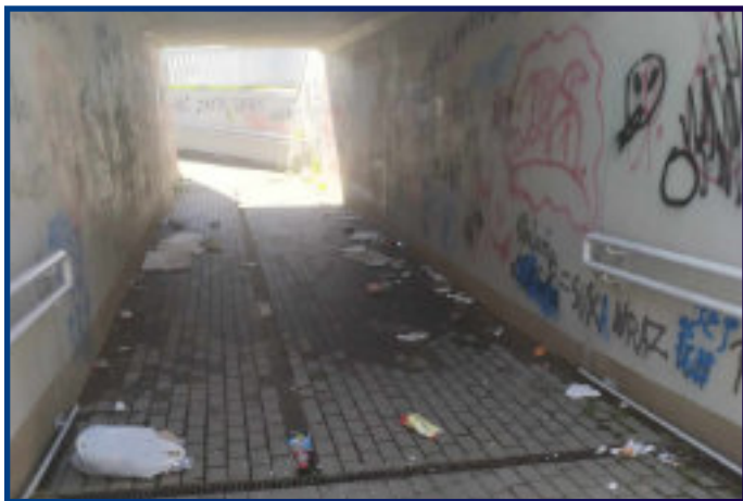
Widok przejścia pod torami
