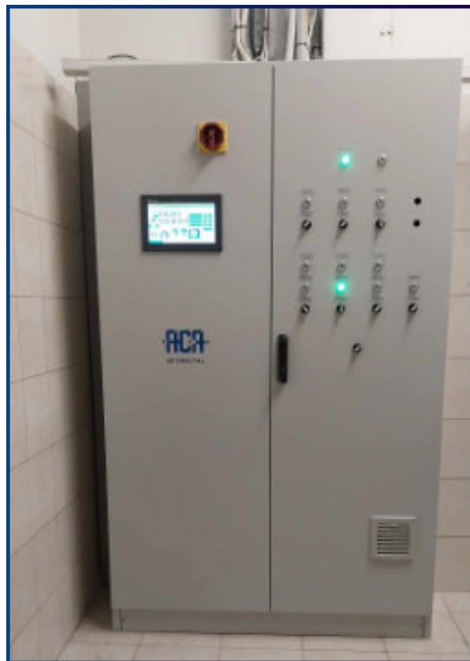
Układ zasilania w SUW
