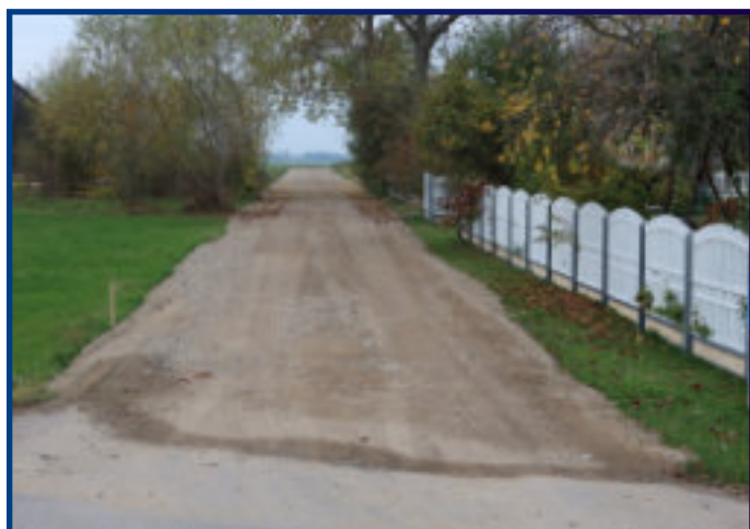
Przebudowana droga Słup-Kolonia - Godlewo-Gudosze
