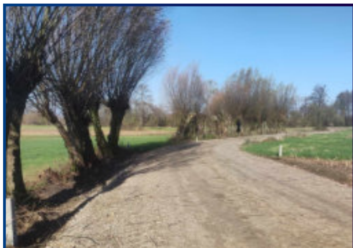
Przebudowana droga w Uścianku-Dębianie
