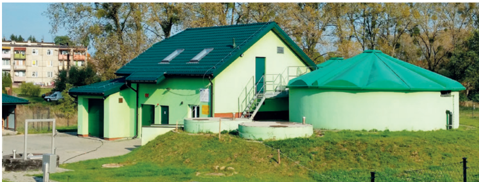
Oczyszczalnia ścieków w Karnkowie
