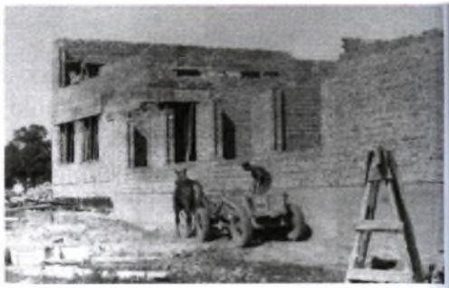
Fot. 31. Szkoła w budowie
