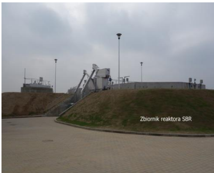
Budynek techniczny i piaskownik pionowy
