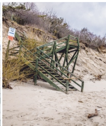
Zejście przed remontem.
