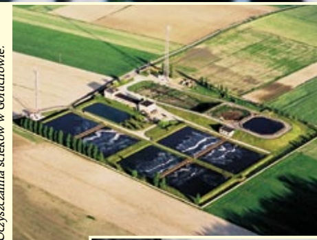
Oczyszczalnia ścieków w Gołuchowie.
